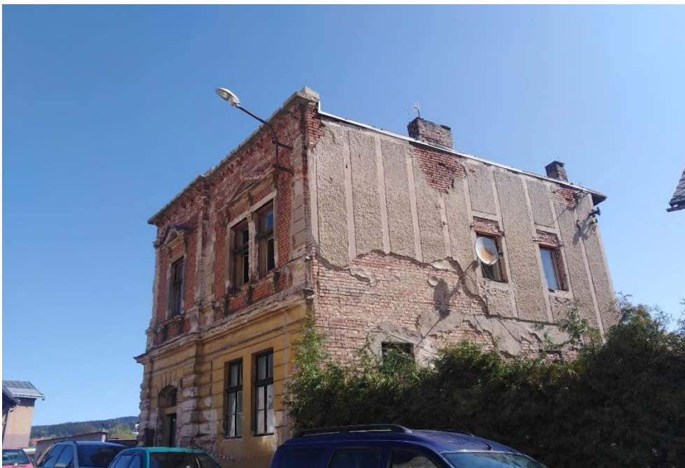
Celkový pohled – uliční a jižní boční strana
