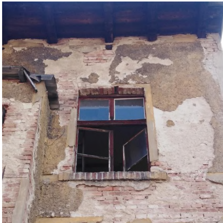
Detail – dvorní strana – okno nad zadním vchodem
