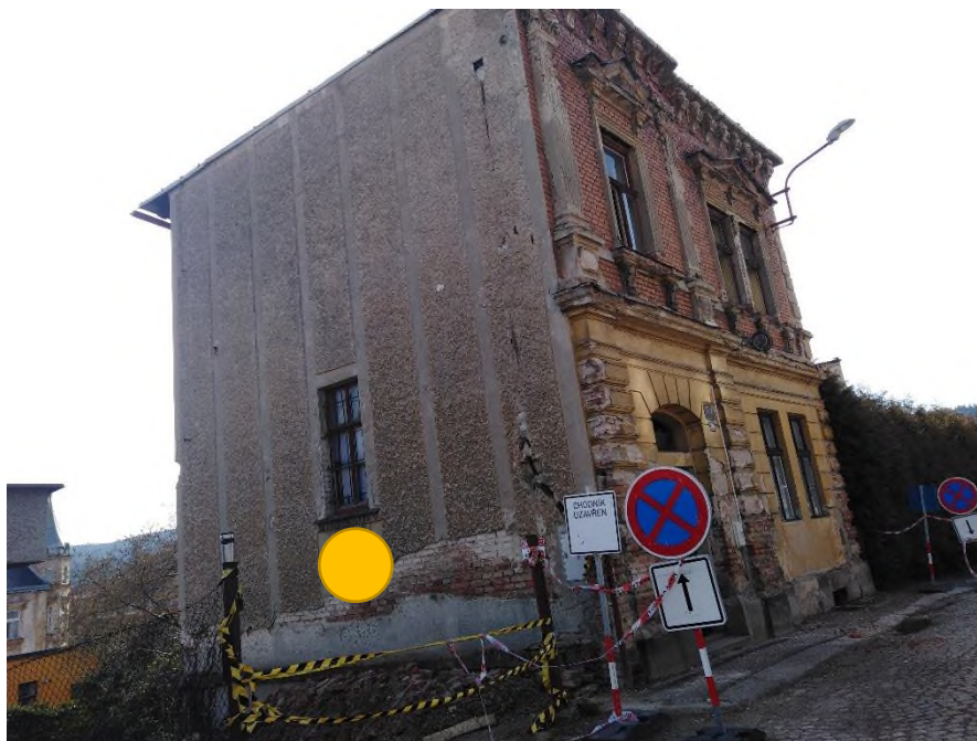
Celkový pohled – uliční a severní boční strana (okno k obnově)
