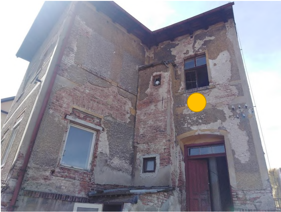
Detail – dvorní strana se zadním vchodem (okno k obnově)
