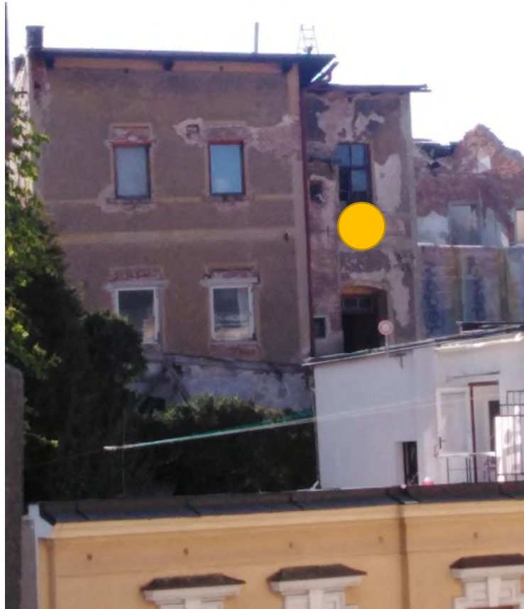
Celkový pohled – dvorní strana (okno k obnově)
