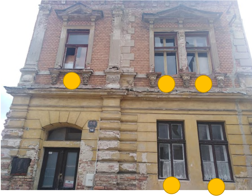
Celkový pohled – uliční strana (okna k obnově)
