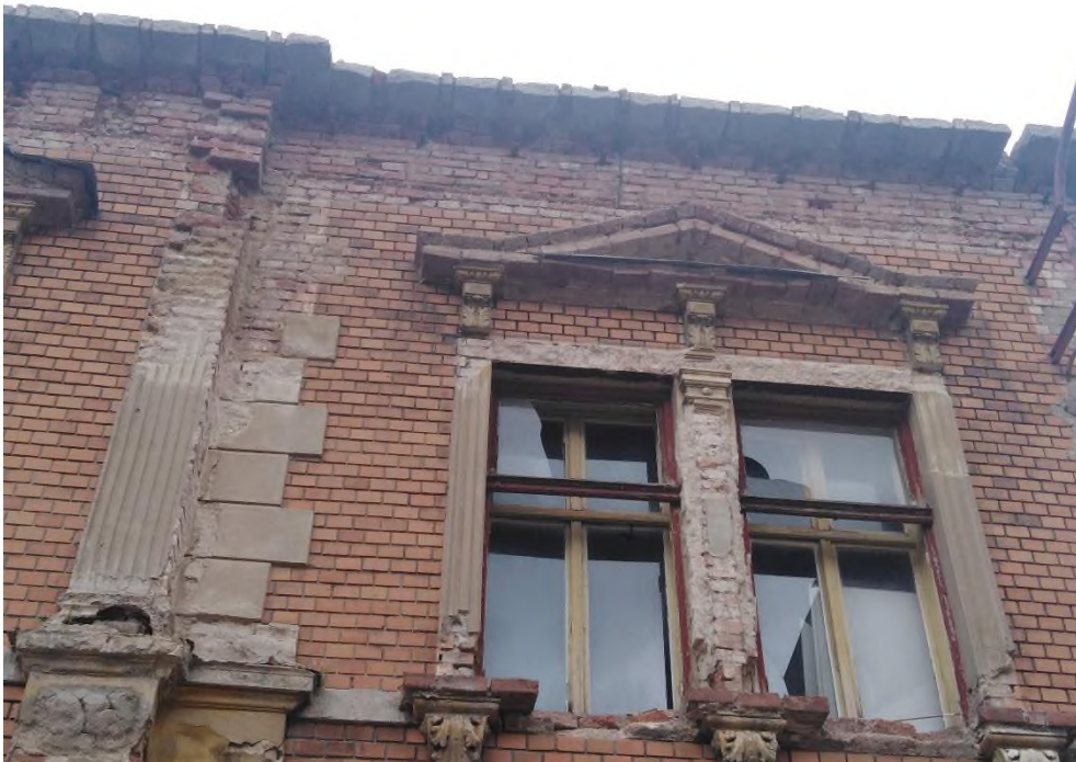
Detail – uliční strana – okno v 1. patře
