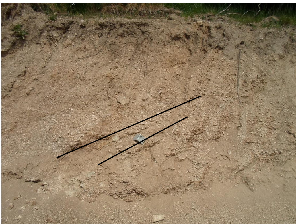
Rozpukání žuly ve směru tektonických linií sudetského směru viz. předešlý detail
