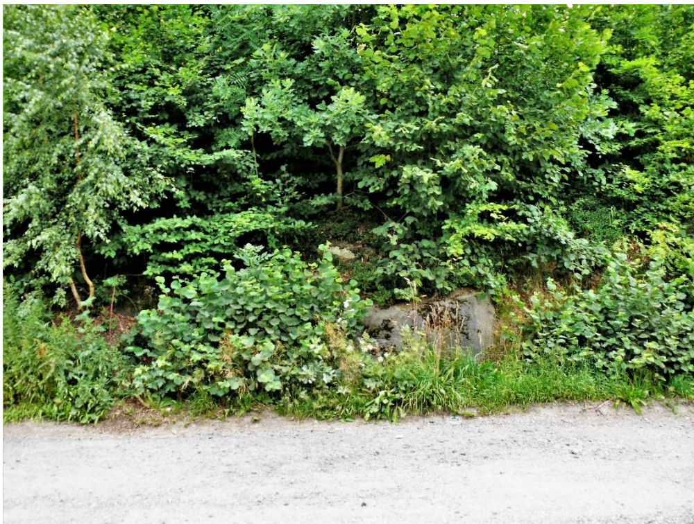
Drobné skalní výchozy neporušené žuly, cca 40 m od zářezu s postiženou žulou na SV, při vjezdu do sběrného dvora. Středně zrnitá biotitická žula (velikost zrn do 1 cm – ojediněle větší růžové živce do 2 cm) plocha pukliny
