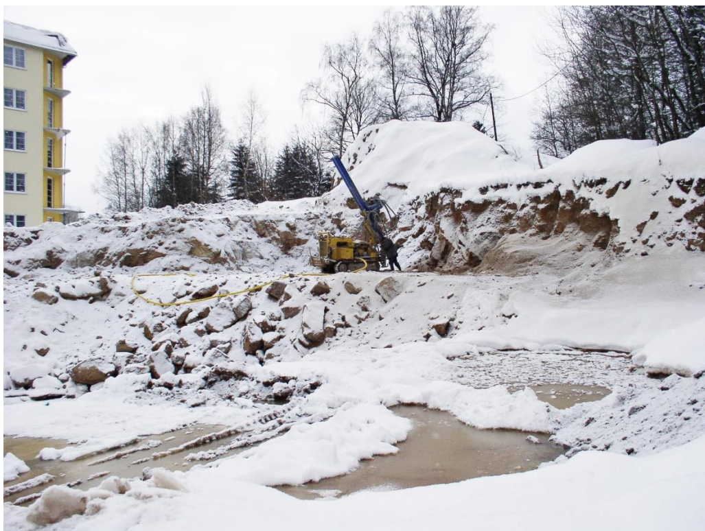
Hloubení základové jámy pro bytový dům
