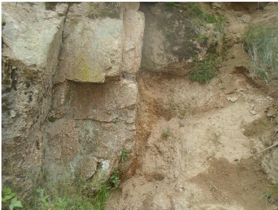
příčné plochy 350^{\circ}/80^{\circ} ; Detail tektonického porušení skalního zářezu ulice
