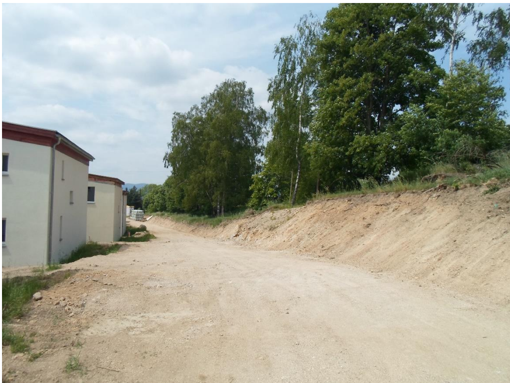
Celkový pohled na III. etáž
