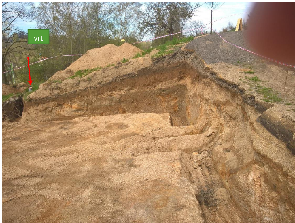
Parcela p. č. 1503/2. 280 m od počátku Horní ulice na ulici Prosečské. Silně rozložená žula libereckého typu s projevy tektoniky s puklinami 60^{\circ}/85^{\circ} ; Výkop pro založení RD
