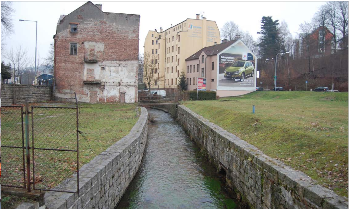
LUŽICKÁ NISA, POHLED SMĚR VÝCHOD VLEVO DŮM 2112
