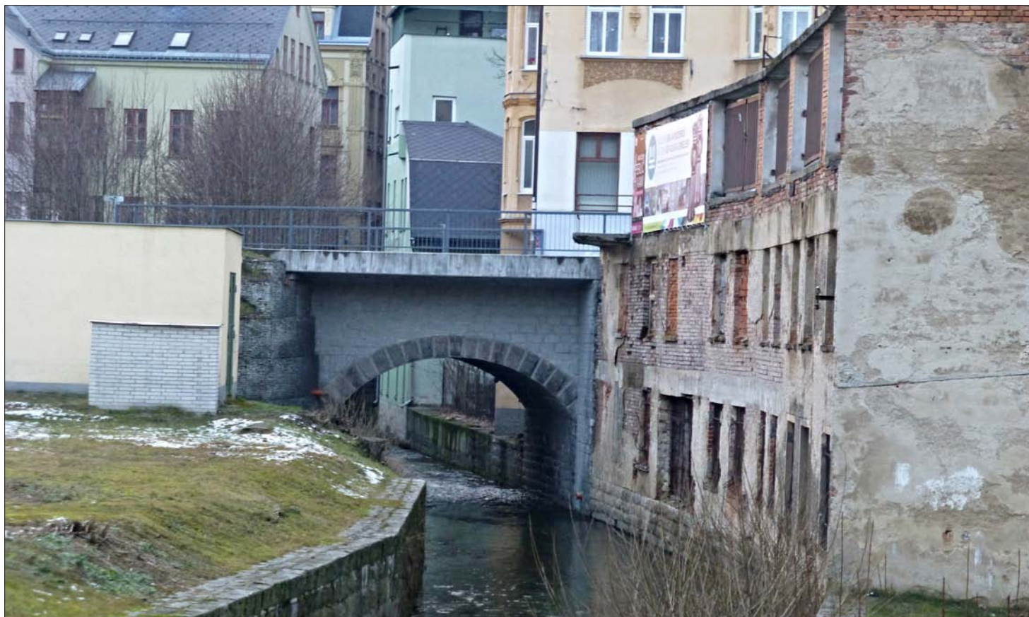
MOST PŘES LUŽICKOU NISU - KAMENNÁ ULICE VPRAVO TORZO BÝVALÉ TRŽNICE
