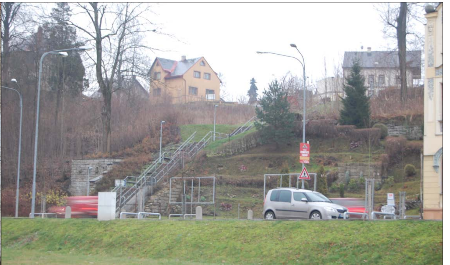
ULICE 5. KVĚTNA A SCHODIŠTĚ SCHODIŠTĚ JIŽNÍM SMĚREM K ŽELEZNIČNÍ ZASTÁVCE JABLONEC N. N. CENTRUM
