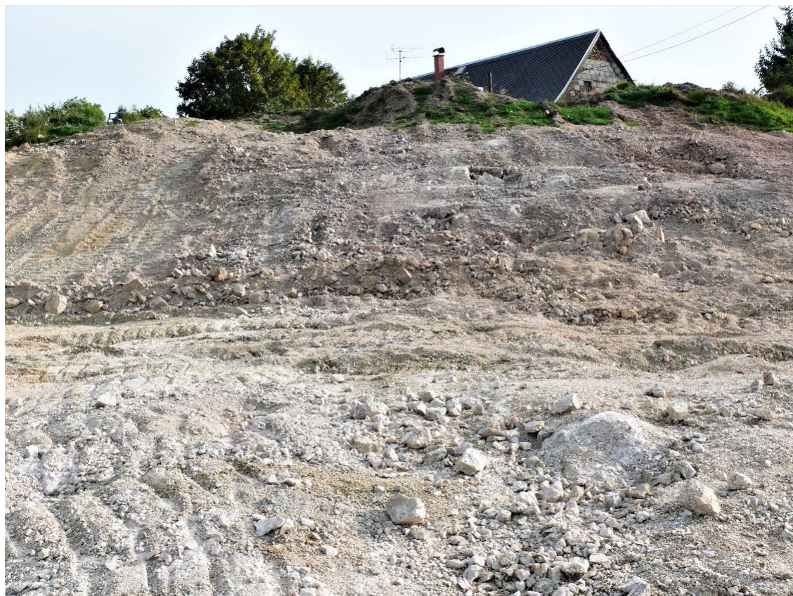
Silné alterace a prokřemenění. Počátek hloubení zářezu v Lukášově západně od přemostění.
