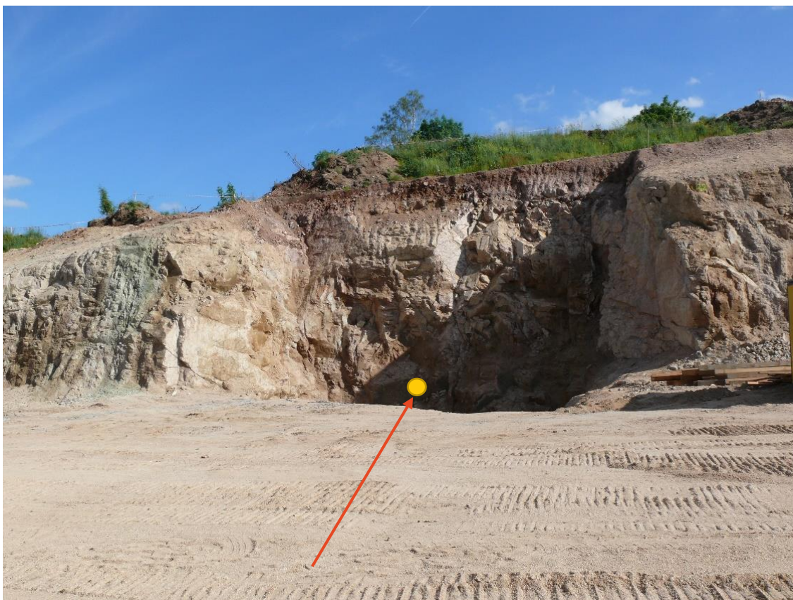
Jáma pro pilíř mostu - souřadnice středu: 50.7470158 N; 15.1333967 E
