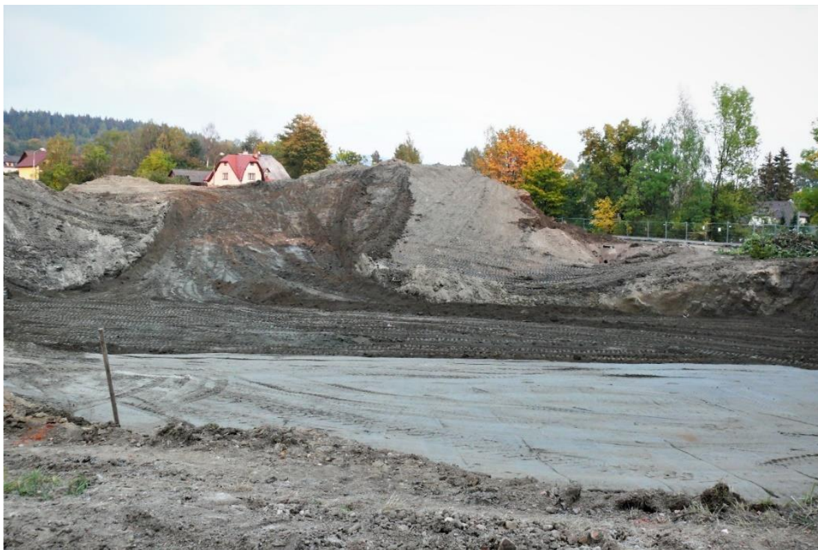
Pohled do základové jámy.
