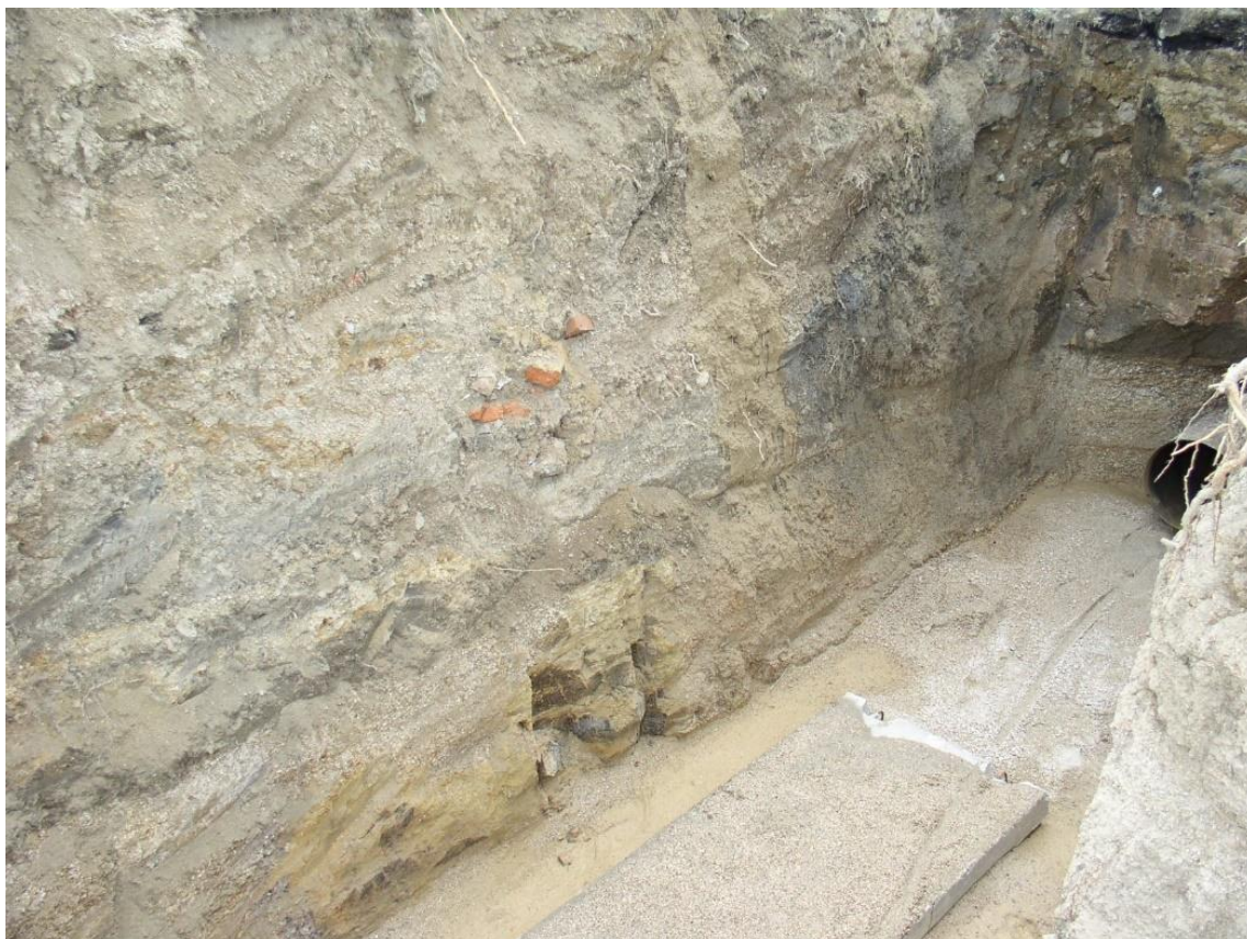
Horizontální vrt pod Ulicí Ladova. Ocelové potrubí tvoří ochranu budovaného teplovodního potrubí. Potrubí je uloženo v pevné zvětralé žule pod kvartérní hlínou a navázkou
