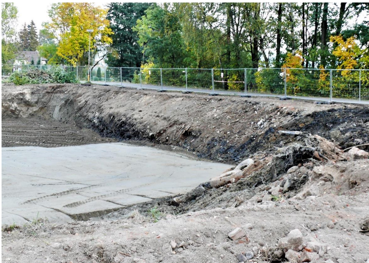
Jáma pro založení haly – původní cesta na okraji je založená na navážce
