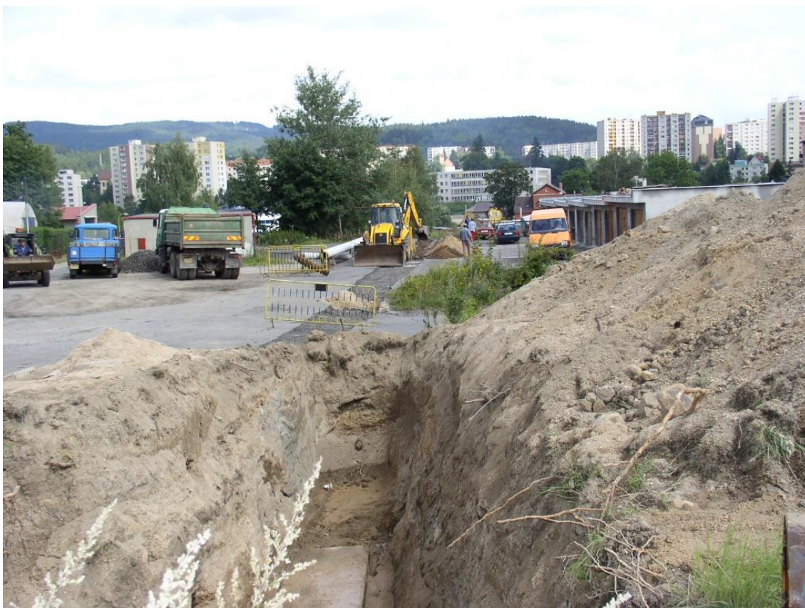
Pohled ve směru výkopu výkop je veden v kvartérních hlínách místy s navážkou
