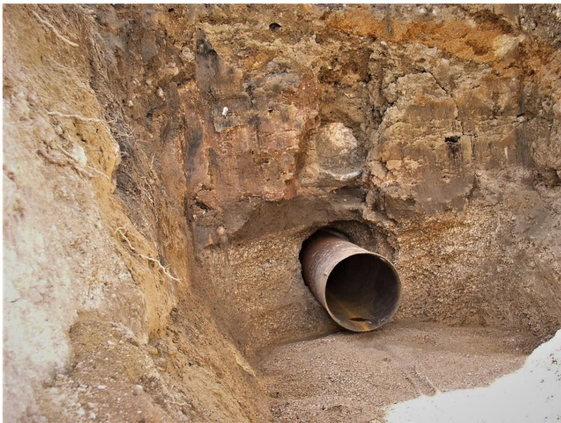
Horizontální vrt pod Ulicí Ladova. Ocelové potrubí tvoří ochranu budovaného teplovodního potrubí. Potrubí je uloženo v pevné zvětralé žule pod kvartérní hlínou a navázkou
