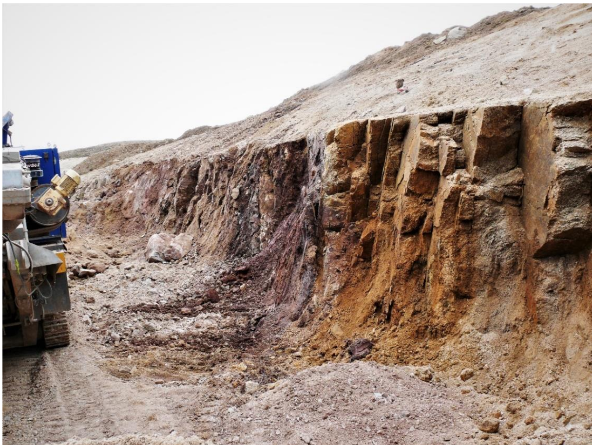
Okraj Lukášovského úseku silnice v místech pod dělostřeleckou šancí. Obnažená melafyrová žíla s okolními alteracemi. Pohled od SZ. Tektonické plochy JV - SZ (lužický směr) se stopami svislých pohybů.
