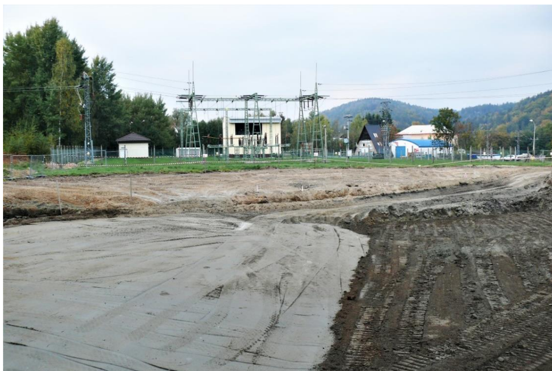
Jáma pro založení stavby haly Jablotronu
