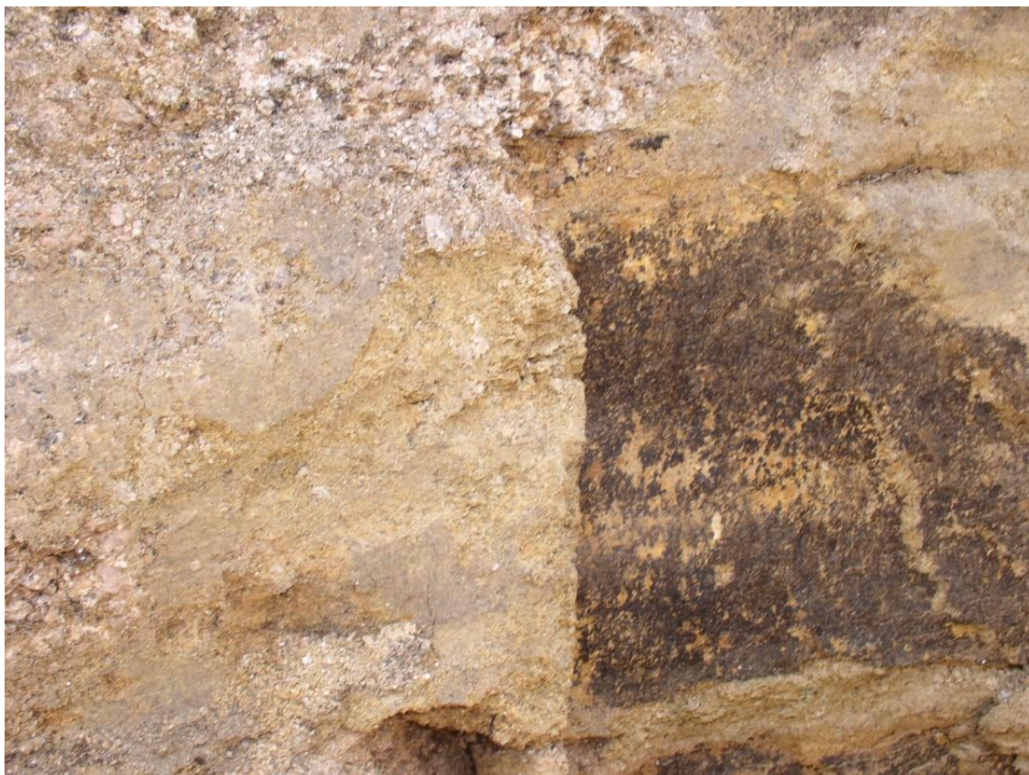
Puklinová plocha s limonitovým povlakem 140°/80°.
