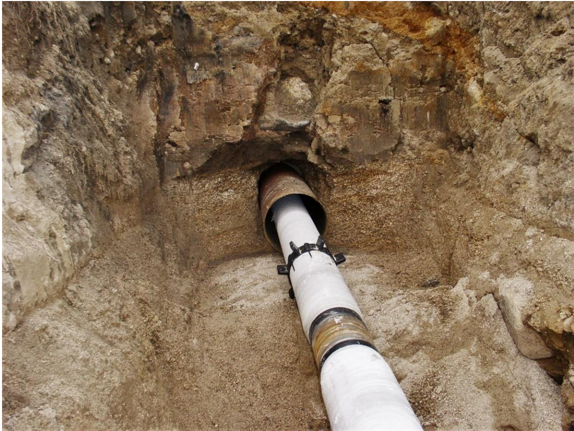
Uložení teplovodu v ochranném ocelovém potrubí pod vozovkou. Rozhraní kvarterních sedimentů a podložní liberecké žuly
