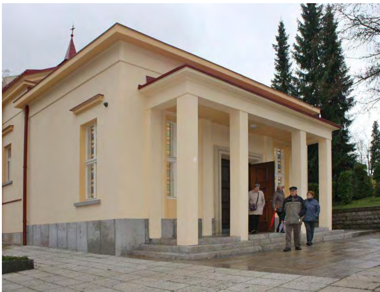
Zrekonstruovaná smuteční síň, foto: M. Hozová
