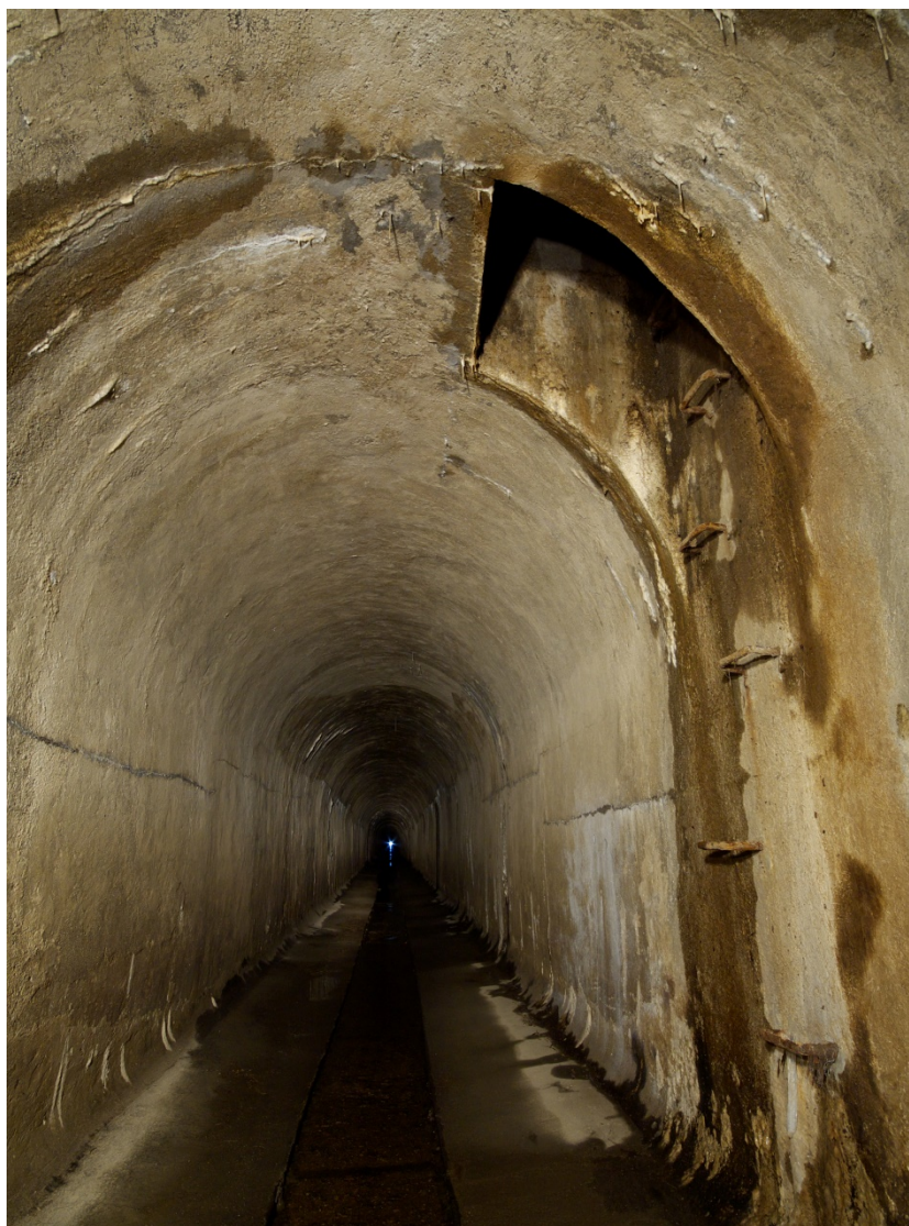
Obrázek 10.4. Loučenský tunel se vstupem do větrací šachty.
