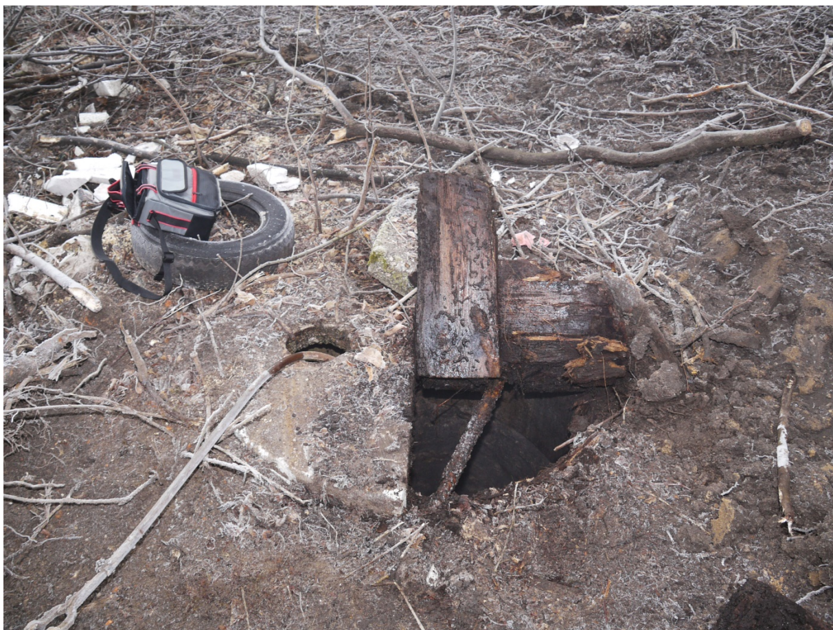
Obrázek 10.26. Studna náhodně odkrytá při zemních pracích.
