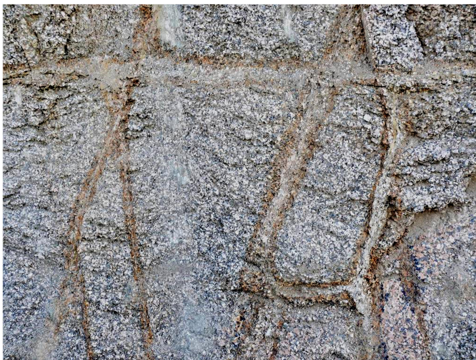
Obr. 3.7. Připovrchová alterace má charakter puklinové sítě v libereckém granitu. Skalní odkryv silničního přívaděče v Lukášově (dokumentační bod UGRB068).
