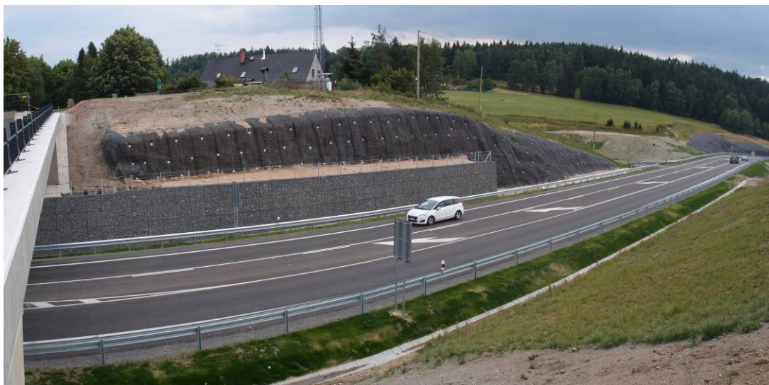
Obr. 3.27. Sanace jabloneckého tektonického pásma v silničním zářezu u Lukášova.
