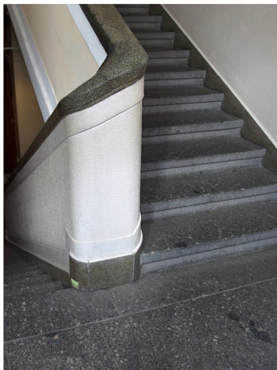
Obr. 11.27. Schodiště z fojtecké žuly v budově střední školy a ZUŠ na Horním náměstí.
