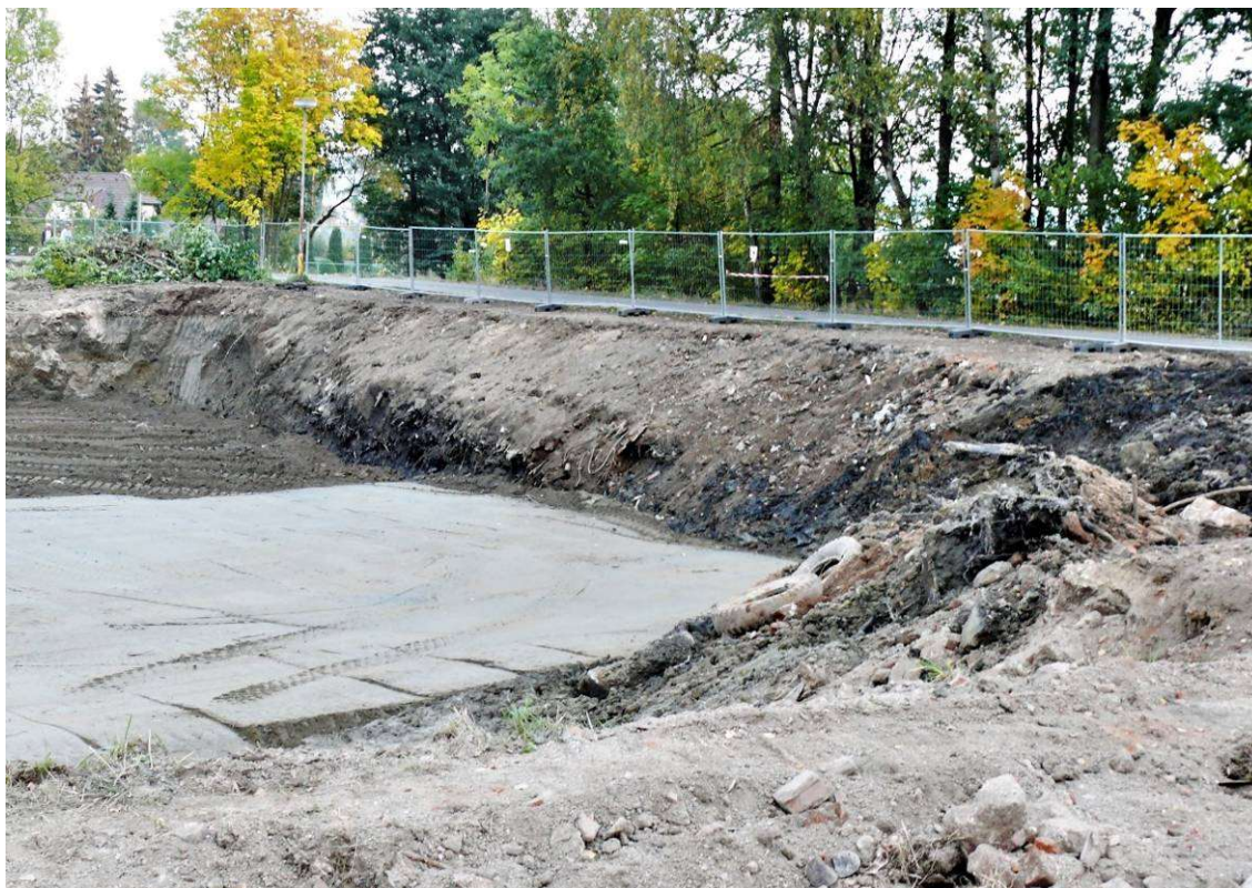
Obr. 3.24. Stavební jáma výrobní haly Jablotronu v sz. části Rýnovic. Původní cesta na okraji je založená na skládce.
