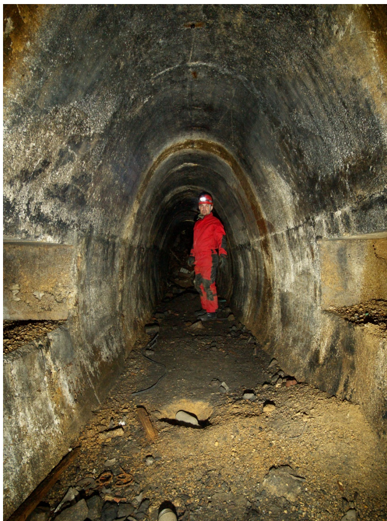
Obrázek 10.16. Hloubené a zastropené protiletecké zákopy v Pivovarské ulici v Jablonci nad Nisou (Pk08, Pk09).
