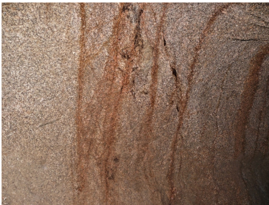
Obrázek 3.26. Charakteristický design sítě puklin reprezentující stopu tektonického zlomu v libereckém granitu (prosečská kanalizační štola).
