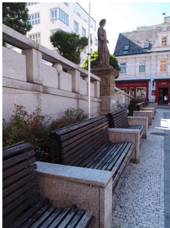
Obr. 11.13. Opěrná zeď a sokly laviček z liberecké žuly, socha Průmyslu a Obchodu z pískovce.
