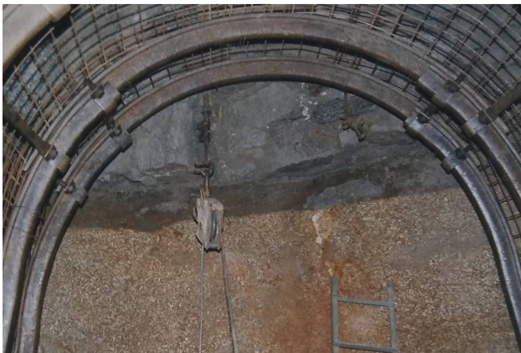
Obrázek 10.15. Základová spára betonových základů hráze v injekční štolě Mšenské přehrady na libereckém granitu (Vrba 1999).
