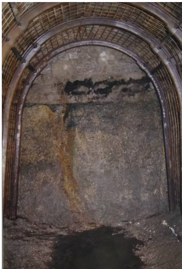
Obrázek 10.14. Injekční štola v podloží hráze Mšenské přehrady. Čelba štoly s kontaktem betonových základů hráze s podložním libereckým granitem. Stěnou čelby prochází tektonický zlom sudetského směru (Vrba 1999).
