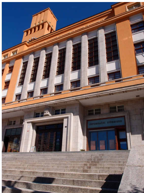
Obr. 11.15. Schodiště a vnější obklady budovy radnice z liberecké žuly.
