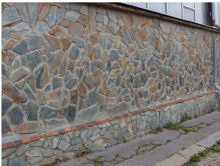
Obr. 11.30. Železnobrodský fylit použitý na obklad budovy školy (SŠ řemesel a služeb) v Perlové ulici.
