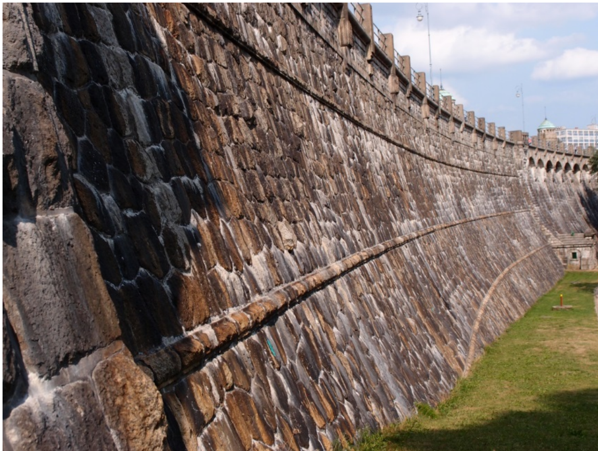
Obr. 11.35. Hráz vodní nádrže ve Mšeně z místní liberecké žuly.
