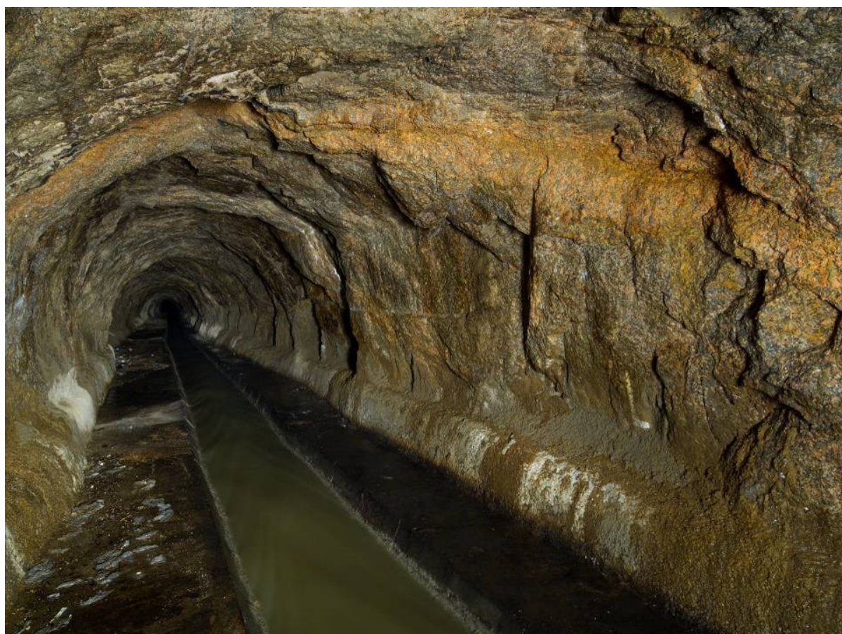
Obrázek 10.11. Pohled na stěny libereckého granitu kanalizačního sběrače Jablonec-Liberec.
