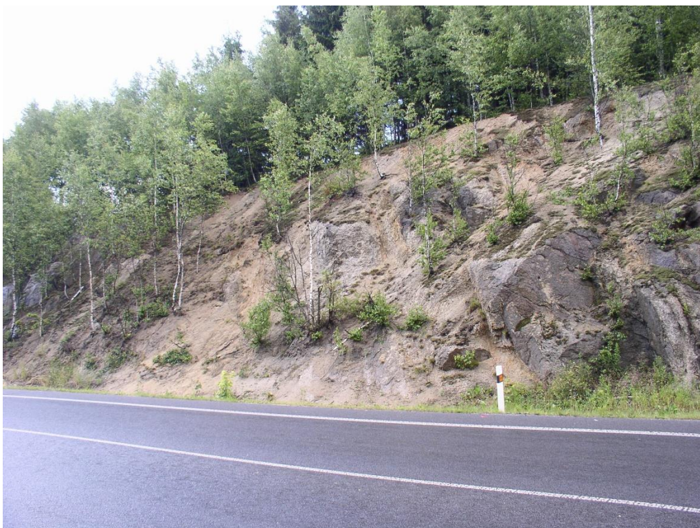
Dílčí celkový pohled na část silničního zářezu.
