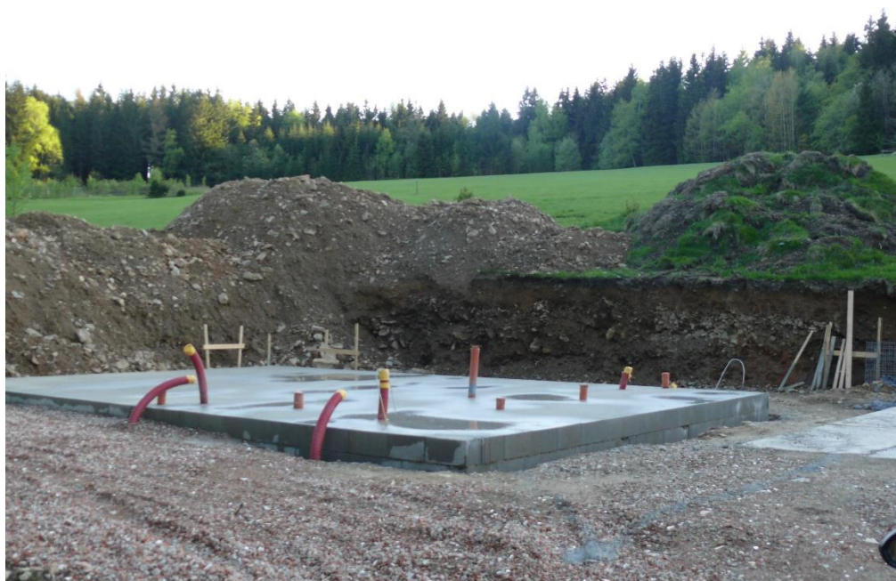
Základová deska celý zářez pro založení RD, až na malý úsek, je v hrubě kamenité suti šedých svorových fylitů
