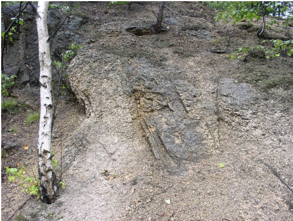
Silně navětralá dvojslídňá žula, 10 m od začátku defilé, pásmo rozpukání cca \frac{1}{2} m, okolní žula silně navětralá (podrcená) úklon ploch rozpukání 60^\circ/80^\circ ,
