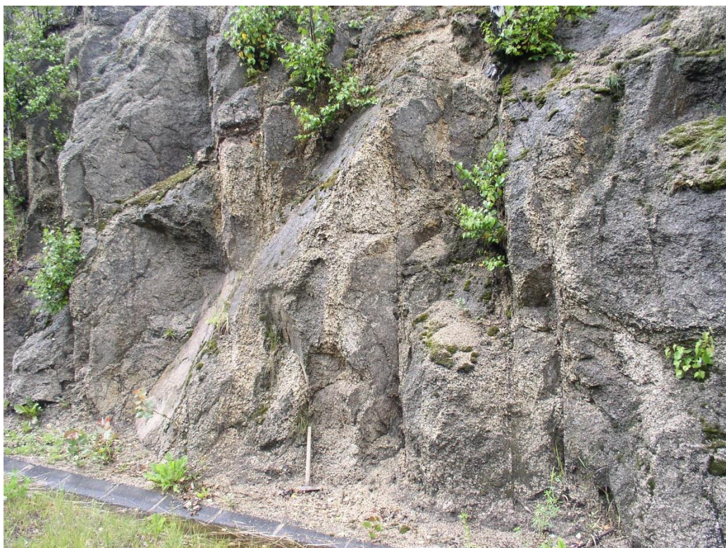
17 m od předchozího bodu, pokračuje postižené pásmo řadou příčných puklin 140°/85°, 140°/80°, 80°/75°, 83°/75°, 85°/80°, 130°/80°, 140°/80°,
