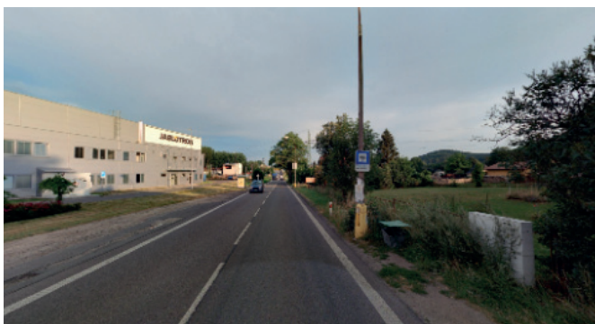
Improvizovaná zastávka ve vozovce zcela bez navazující pěší infrastruktury a vybavení.
