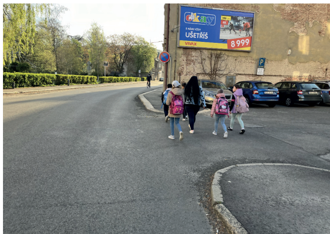
Absence chodníkových přejezdů v místech, kde se z komunikací odbočuje mimo prostor pozemní komunikace, avšak stavebně je vizuálně prostor řešen jako křižovatka a práva a povinnosti chodců a odbočujících či vyjíždějících vozidel jsou tak nejasné / jsou vzájemně v rozporu.
