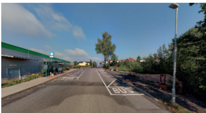
Autobusová zastávka v blízkosti hypermarketu bez potřebného vybavení, zejména bez bezpečného přístupu a nástupní hrany.
