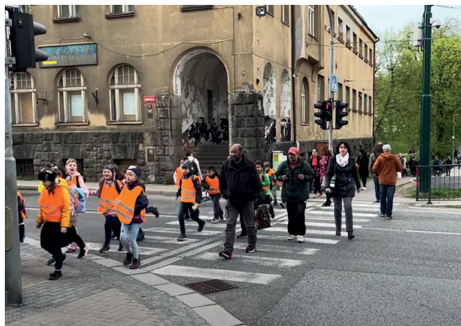
Jeden z nejvytíženějších přechodů pro chodce a Jablonci nad Nisou má v rámci signalizace volno jen 7 vteřin – kapacitně nevyhovuje zejména vyčkávací prostor v kontextu intenzit chodců a krátkého chodeckého volna.
