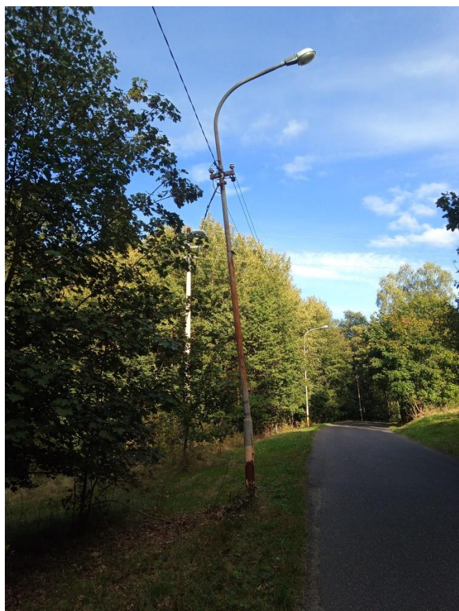
Obrázek 5 - Neuspokojivý technický stav lamp veřejného osvětlení. Foto: Filip Brus 30. 9. 2024.
