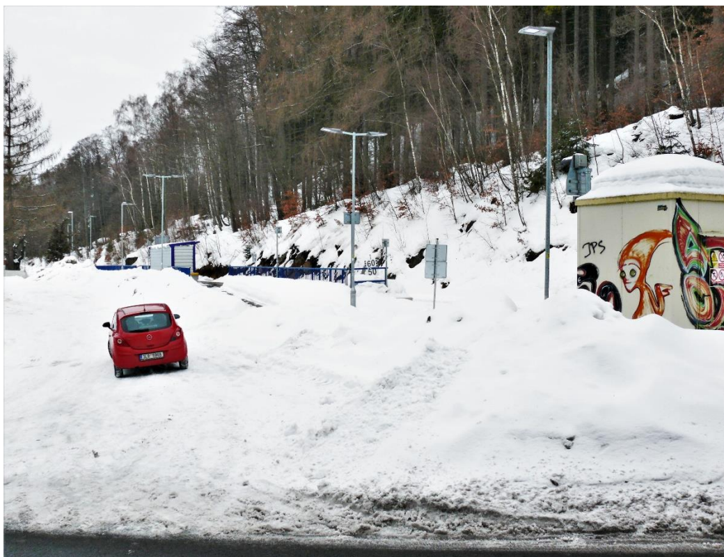
Současný pohled na zářez kolejiště do svahu.
