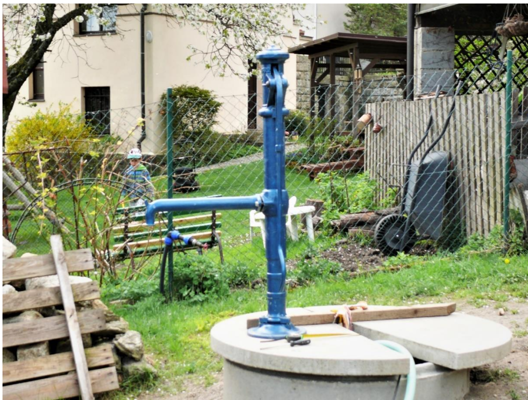
Nová studna je hluboká 5.30 m od terénu, Voda se ustálila ve 3,15 m od hrany zhlaví
