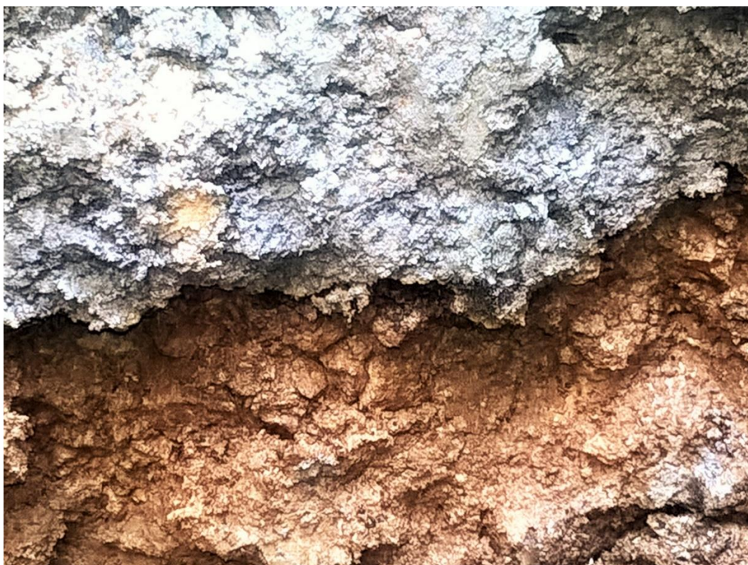
Přechod šedých jíílů s balvany žuly do rulového eluvia. Přechod je cca 20 cm s drtí drobných úlomků ruly
