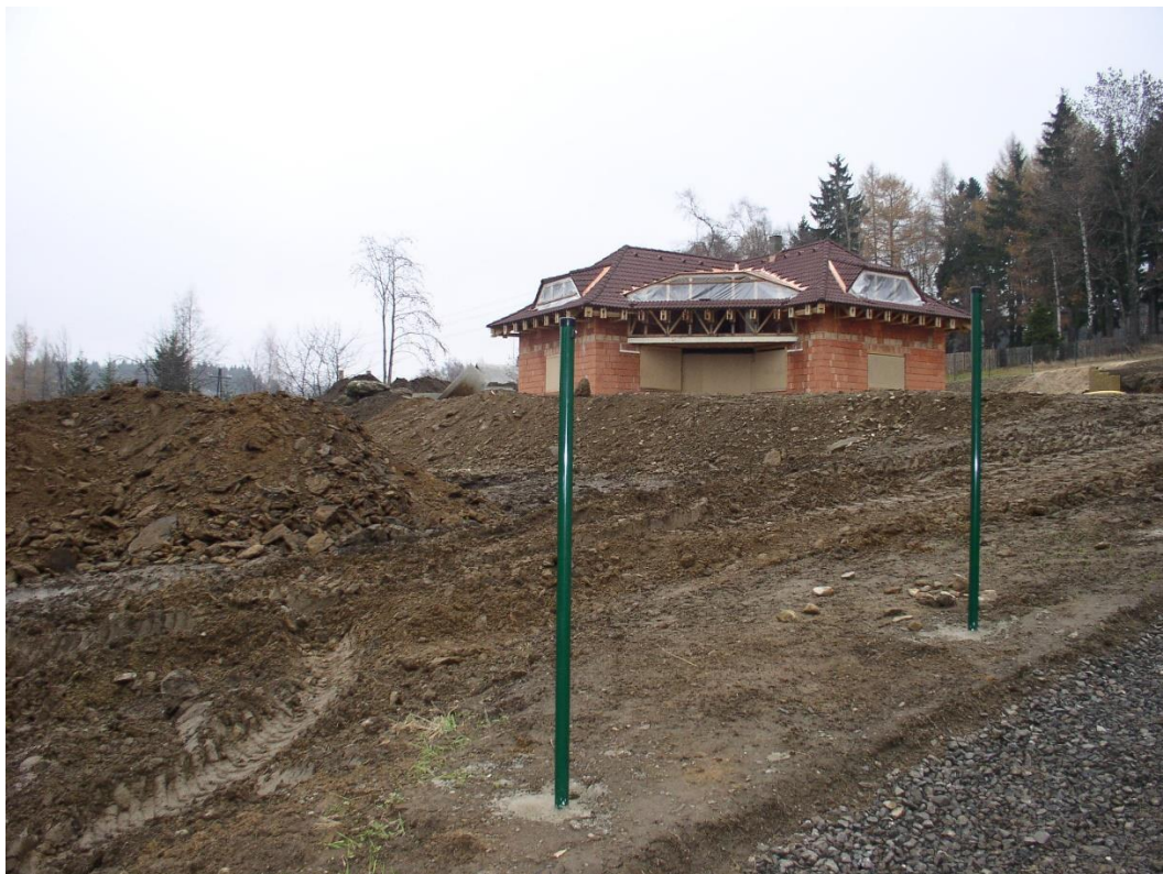
Pohled na stavbu RD 3.12.2003
