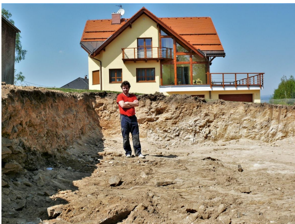
Pohled ve výkopu k S
