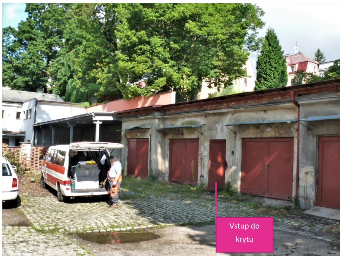
Vstup do podzemí mezi garážemi.
