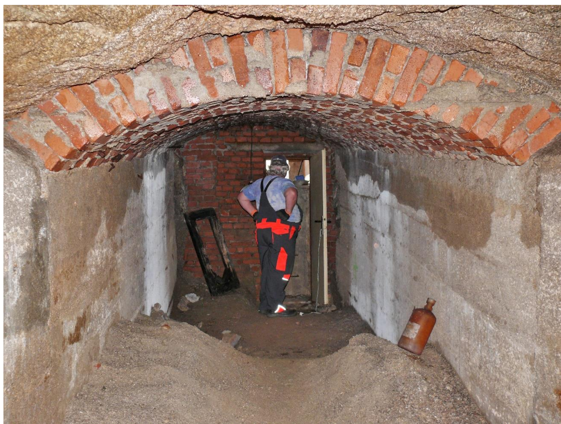
Pohled na vstupní část z vnitřku krytu
