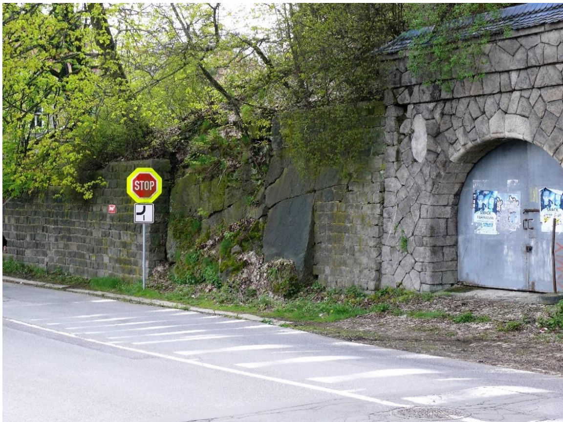
Levý jihovýchodní okraj opěrných zdí s vjezdy do podzemí
