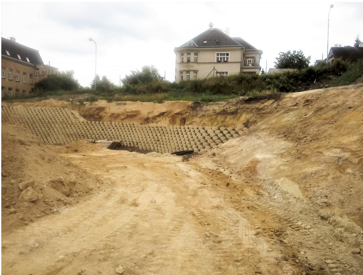
Výkop pro školní hřiště, který byl v ve velmi krátké době zastavěn gabionovou stěnou.
