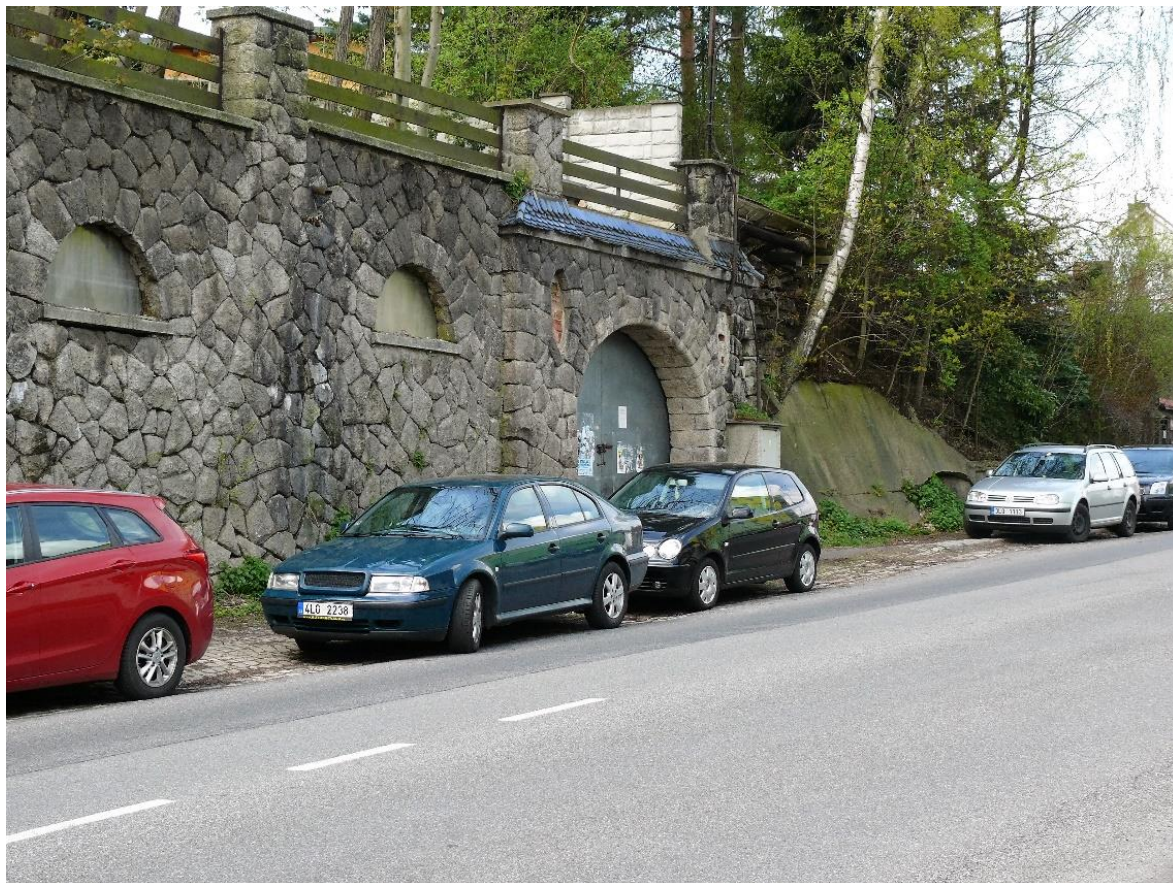
Severozápadní okraj zdiva, menší skalní výchoz za okrajem zdi č. 2
