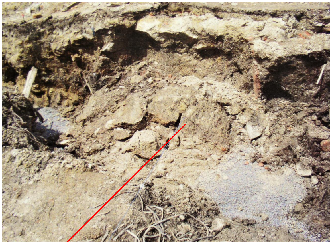
Obnažené podloží, silně zvětralá žula libereckého typu
