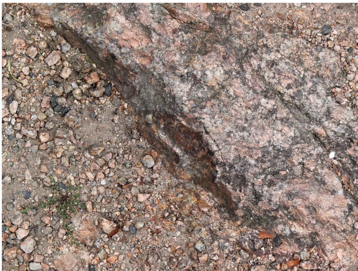
Výrazná puklina s ohlazením a povlakem limonitu, žula má silný červenavý nádech. Výchozy Ve vozovce mezi garážemi.
