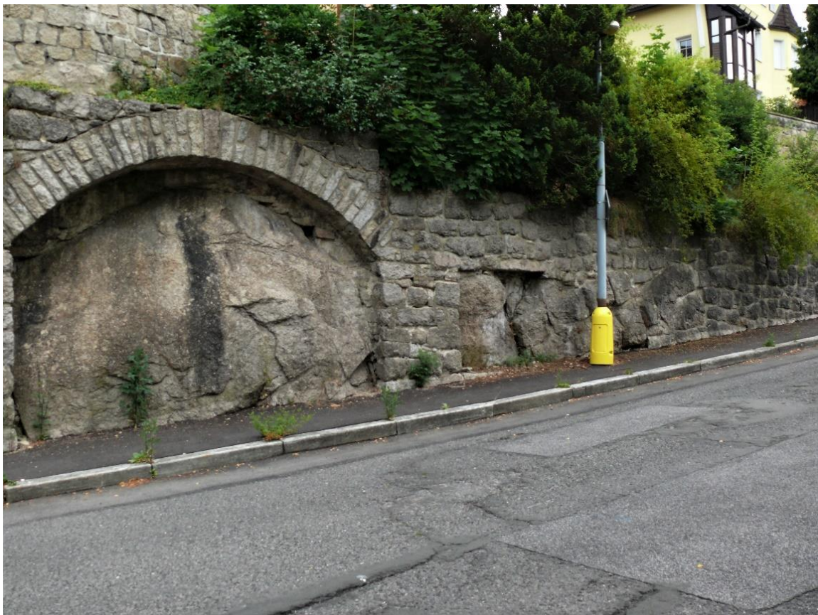
Pukliny: 105^{\circ}/70^{\circ} 5 cm široká s výplní žulové drti; 125^{\circ}/75^{\circ} (4x); 210^{\circ}/85^{\circ}
