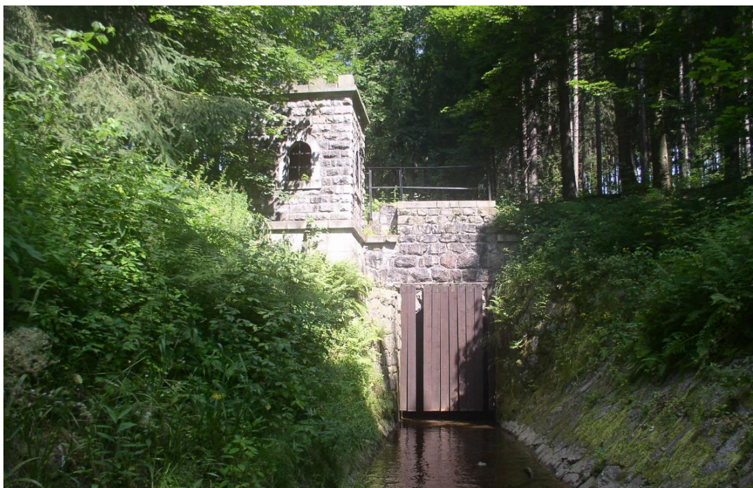
Portál tunelu ve Mšeně nad Nisou
